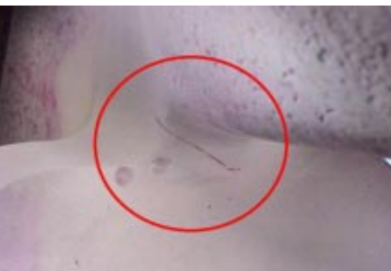
Bild 7 Rissentwicklung an der Becherwurzel.
