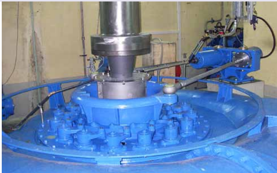
Neuer Antrieb des Leitapparates.
