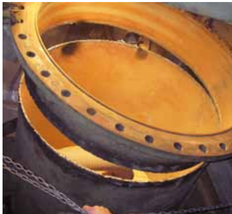
Abtrennen und kürzen des Druckleitungsrohrs.
