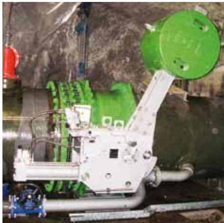
Die neue Leitungsführung nach abgeschlossener Arbeit.
