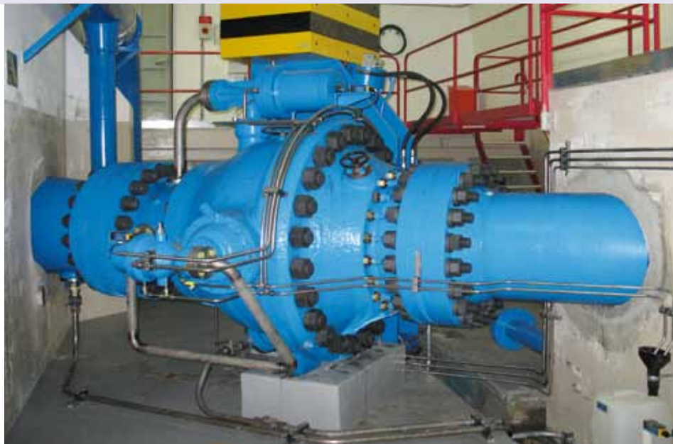
Mit der Revision wurde der Kugelschieber auf fettfreien Betrieb umgebaut.
