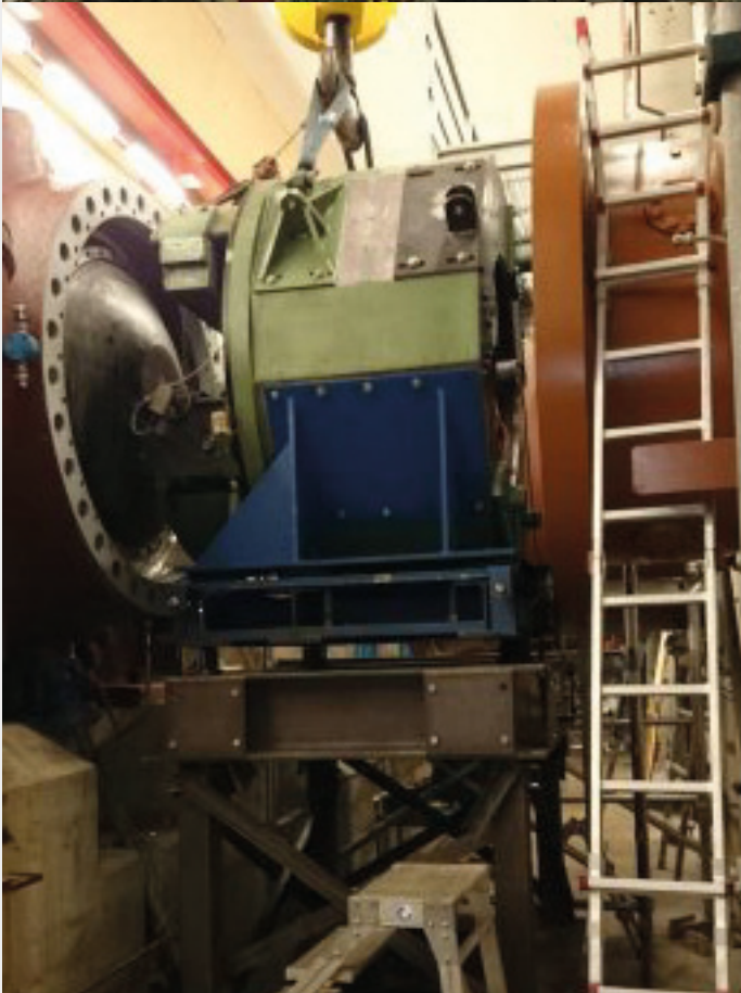
Drehen und Schleifen des Schleifrings im Kraftwerk Hopflauenen in eingebautem Zustand.
