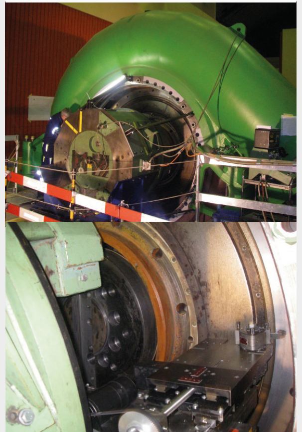
Aufarbeitung der Passflächen des Diffusors an der Pumpenspirale im Kraftwerk Grimsel 2.
