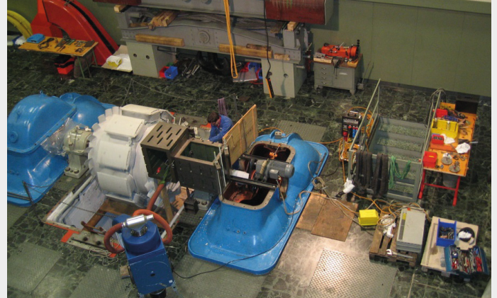
Drehen und Schleifen des Schleifrings im Kraftwerk Hopflauenen in eingebautem Zustand.
