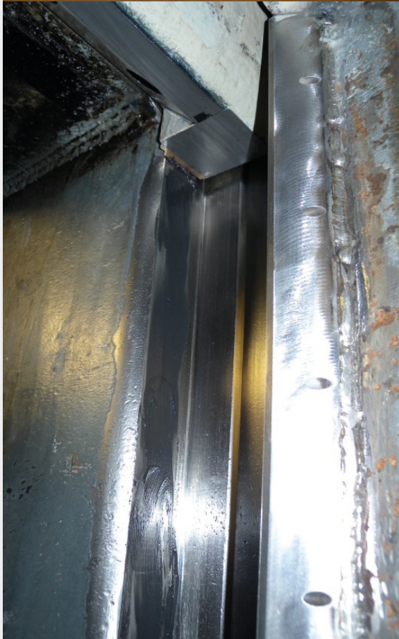
Bearbeitung der Dichtflächen der Tafelschützen an der Spitalamm Sperre (Kraftwerke Oberhasli AG).
