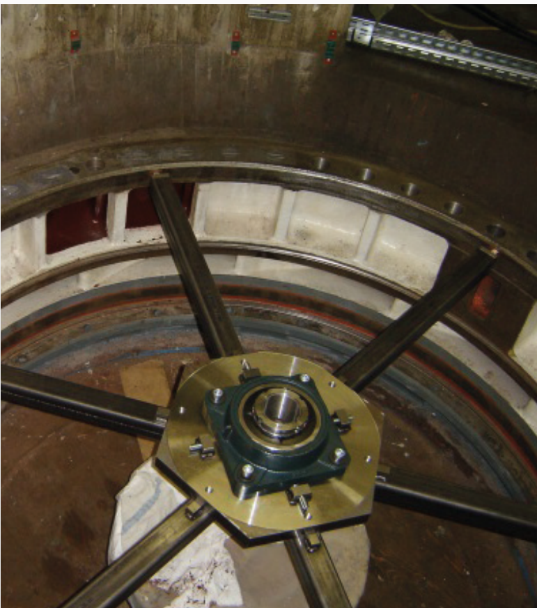
Bearbeitung der Planflächen an der Pumpenspirale Kraftwerk Rosshag.
