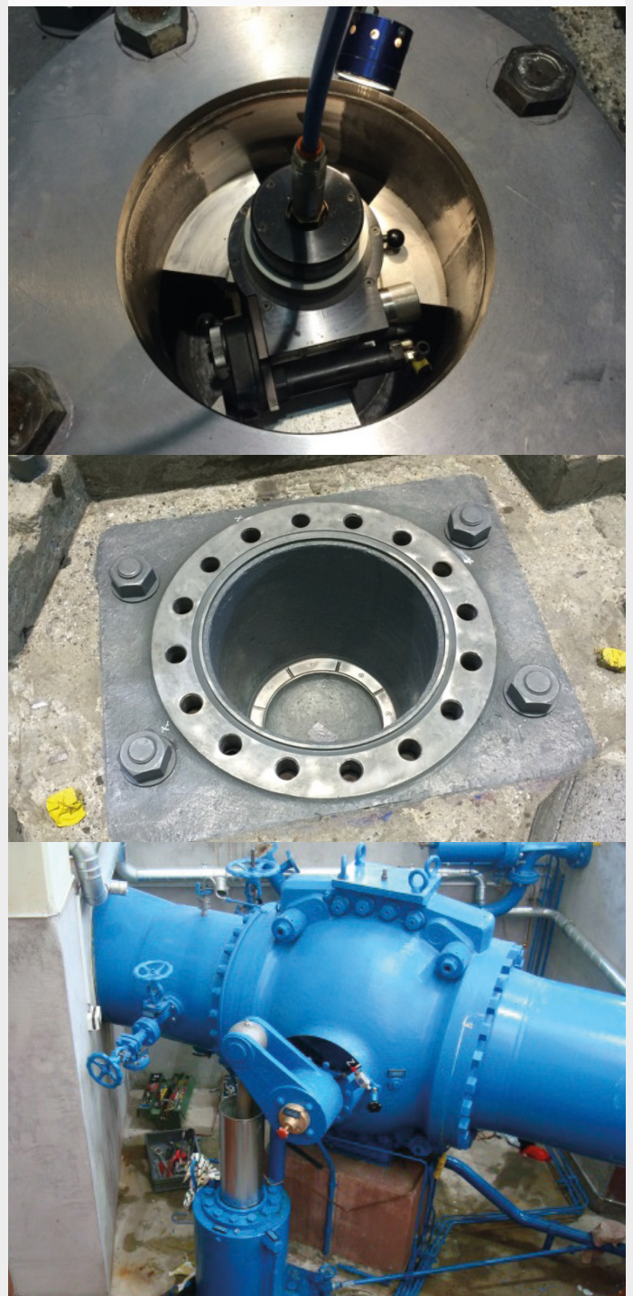
Aufarbeitung des Anschlages am einbetonierten Zylinder im Kraftwerk Tavanasa und Kraftwerk Tinizong.
