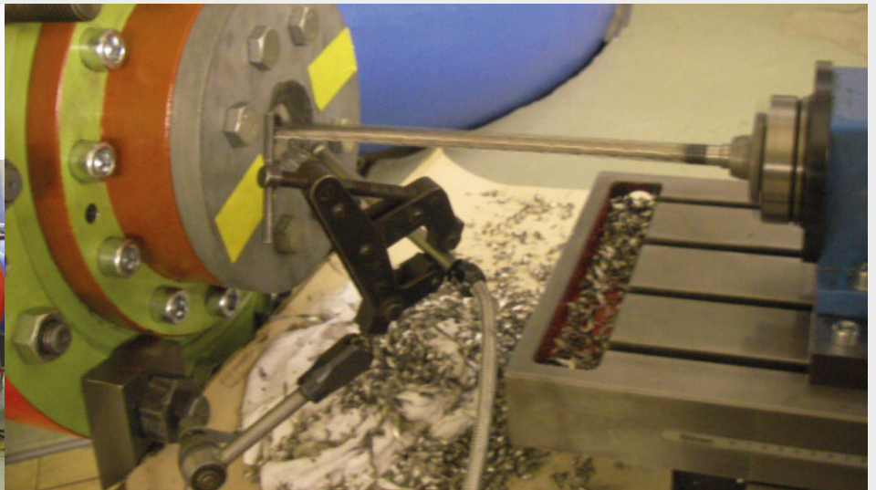
Nachrüstung eines Wegsystems im Kraftwerk Handeck 2 an den Kolbenstangen.
