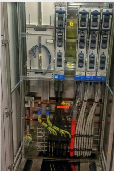
Niederspannungs-Hauptverteilung bis 360 A
