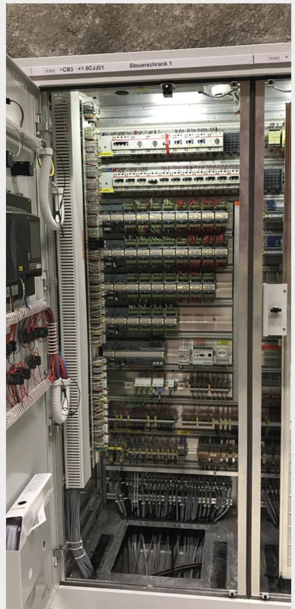
Aufbau, bestücken und verdrahten von Maschinensteuerung und Leittechniksschränken
