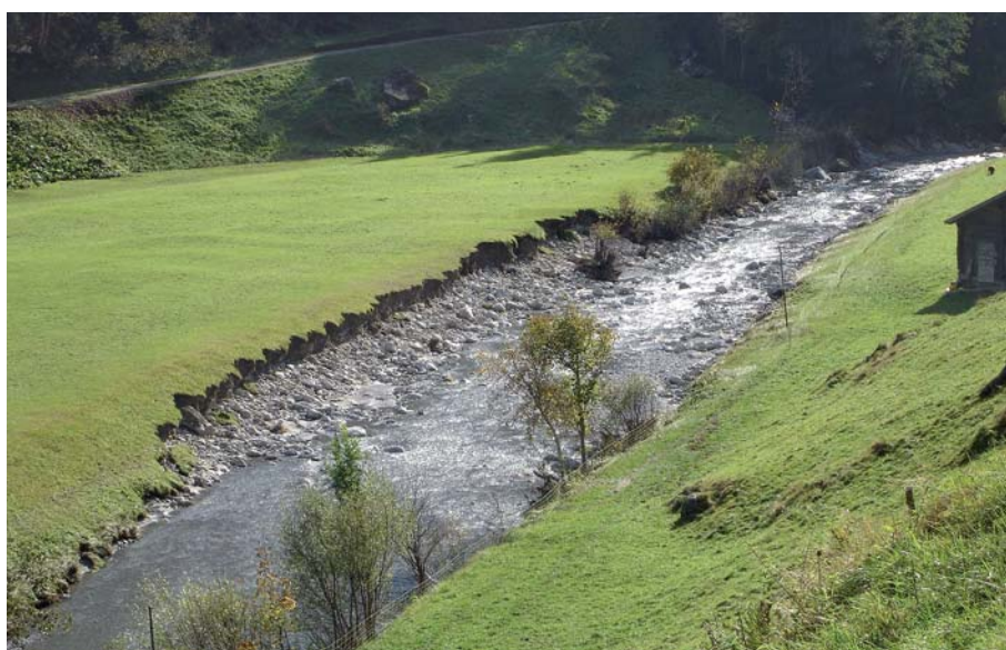
Bild 4. Ansicht auf den unteren Abschnitt der künftigen Flussrevitalisierung Fuhren-Süd. Das Hochwasser vom 10.10.2011 hat bereits erste ökologische Arbeiten in diesem Abschnitt vorweggenommen.
