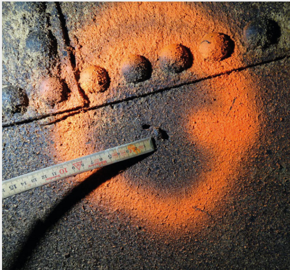
Lochfrass bei Druckleitung
