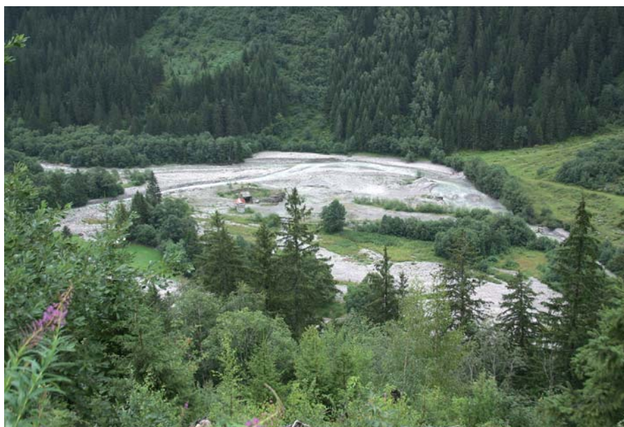
Bild 2b. Lage der künftigen Aue Obermad. Das Steinwasser verläuft links oben im Foto. Foto Dr. H.P. Tscholl.
