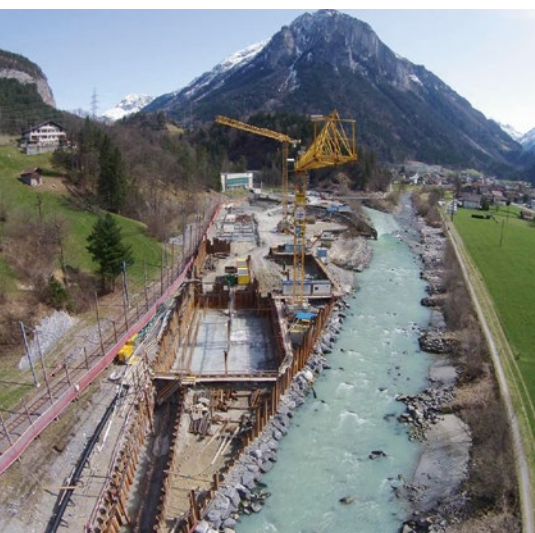
Bild 3: Illustration der Baustelle des Beruhigungsbeckens (Stand Frühling 2014) (Quelle: KWO)
