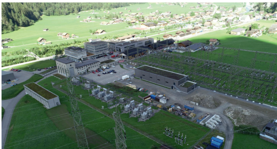
Die alte 220 kV-Freiluftschaltanlage wird nächstes Jahr komplett abgebaut.
