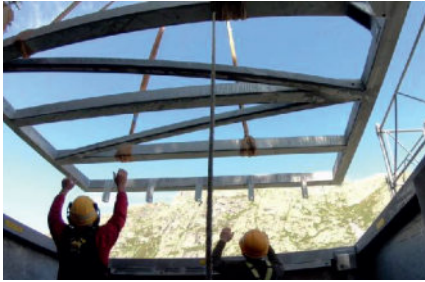
Montage der Dach-Tragkonstruktion
