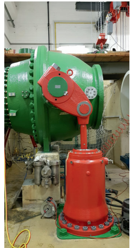
Montage des revidierten Kugelschiebers
