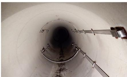
Durchflussmessung alter Druckschacht
