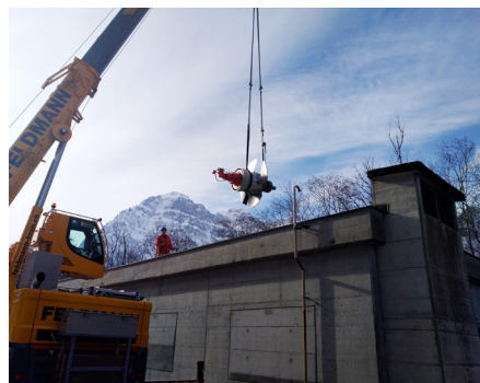
Einheben des vormontierten Laufrades
