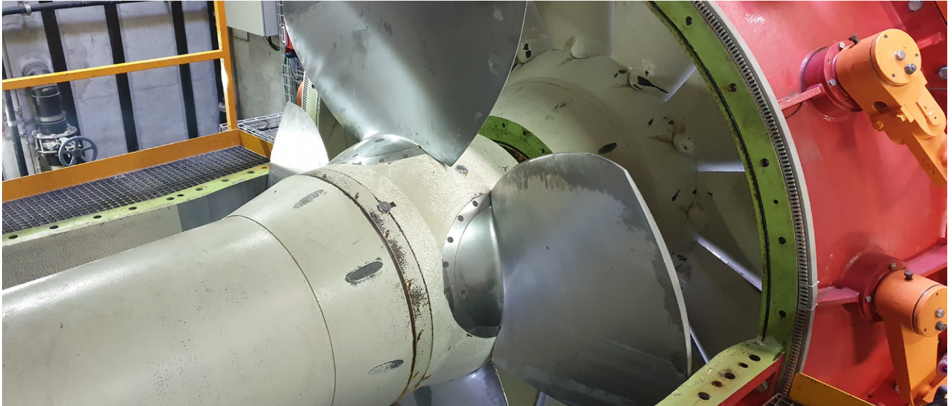
S-Rohrturbine aus dem Kraftwerk Elggis
