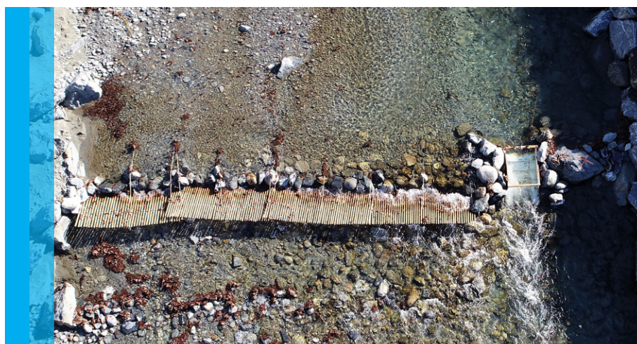
Die Fischzählanlage im Gadmerwasser
