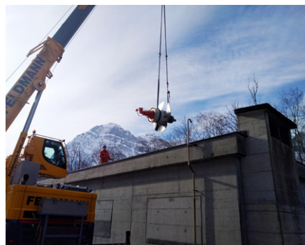
Einheben des vormontierten Laufrades
