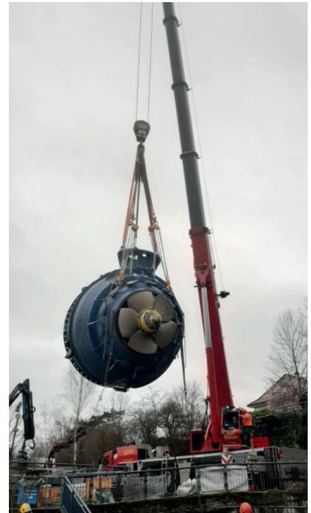
Turbinendemontage mit einem Pneu-Kran
