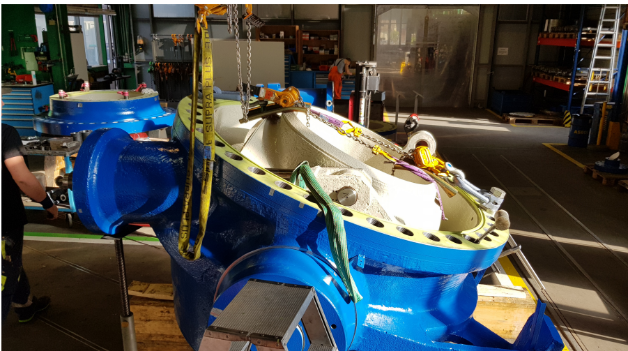
Montage des Kugelschiebers in der Werkhalle von Grimsel Hydro
