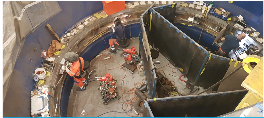
Aufpanzerung der Stützschaufeln
