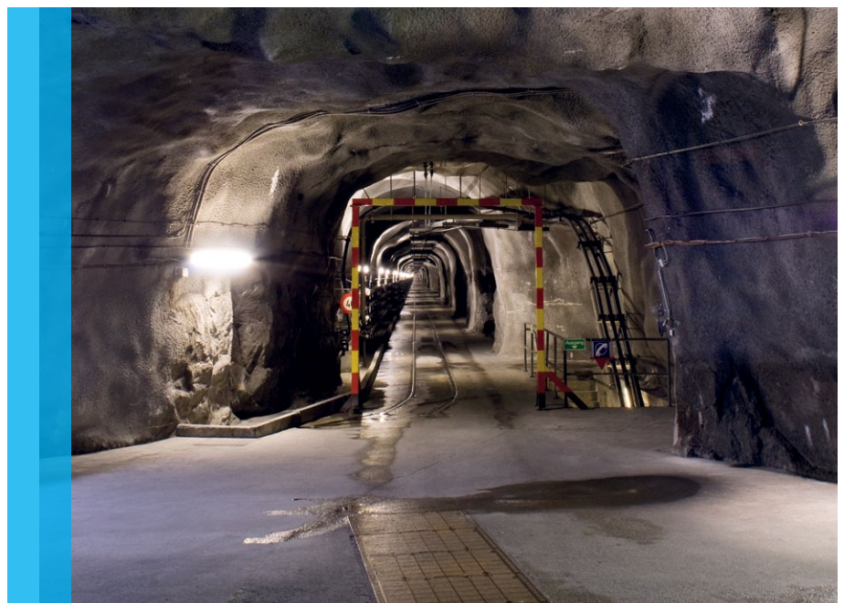
Viele Mitarbeitende sind täglich im unterirdischen Stollen-Labyrinth unterwegs.
