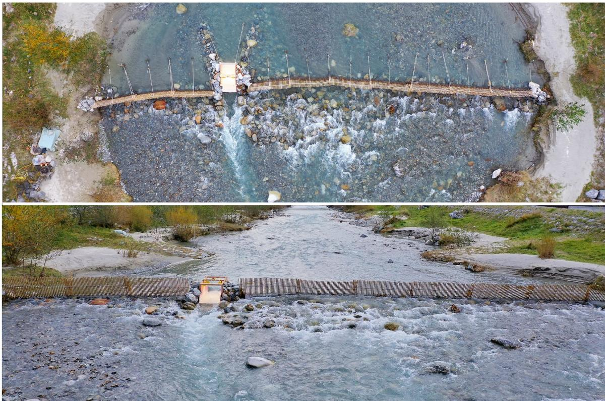
**Bild 2:** Fischwiderstandszähler (FZA 1) mit Leitsystem
